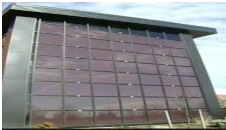
Fig. 1. BIPV Façade
